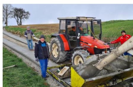
Mit Betonspuren wie hier am Hagberg werden Wege unwettersicher befestigt.
